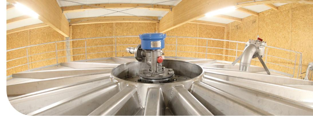
Der neue Hochbehälter im Oberen Moos in Erpfting ist ein Rundbehälter in kompletter Edelstahlbauweise. Moderne Technik stellt die Kontrolle und die Versorgung stetig sicher.
