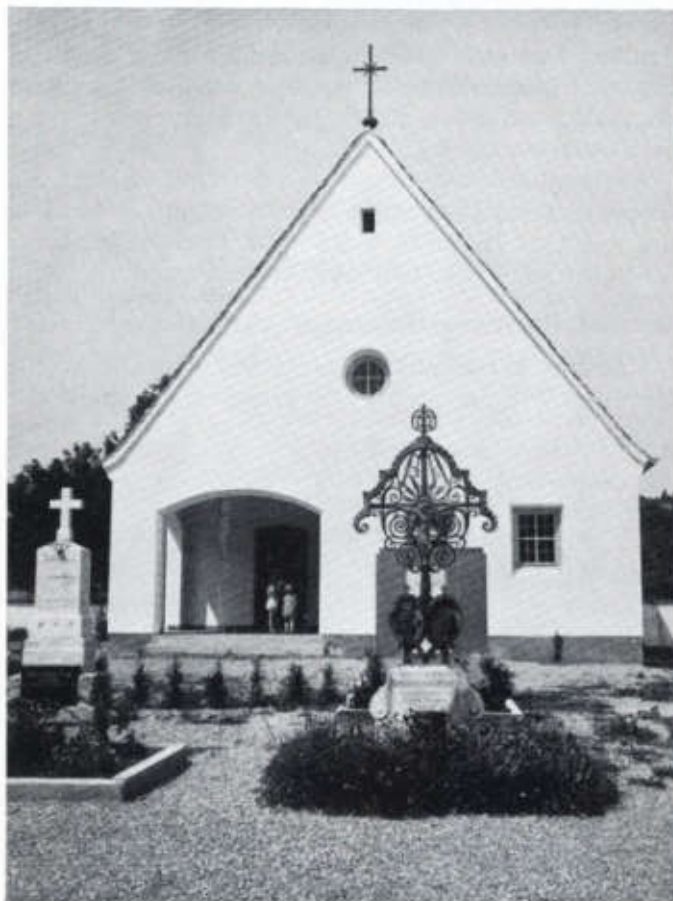
Leichenhaus – 1953 erbaut – Pfarrstadel abgebrochen
