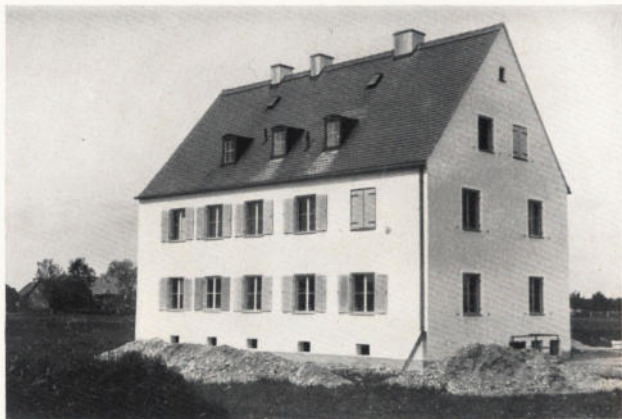
Das erste im Rahmen des sozialen Wohnungsbau 1954/55 von der Gemeinde errichtete Fünffamilienwohnhaus im neuen Siedlungsgebiet, kurz vor seiner Vollendung
